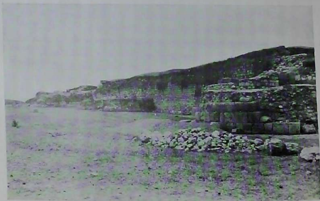
Fig. 41. — Capidava : les murs d'enceinte vus du côté Nord-Est.
