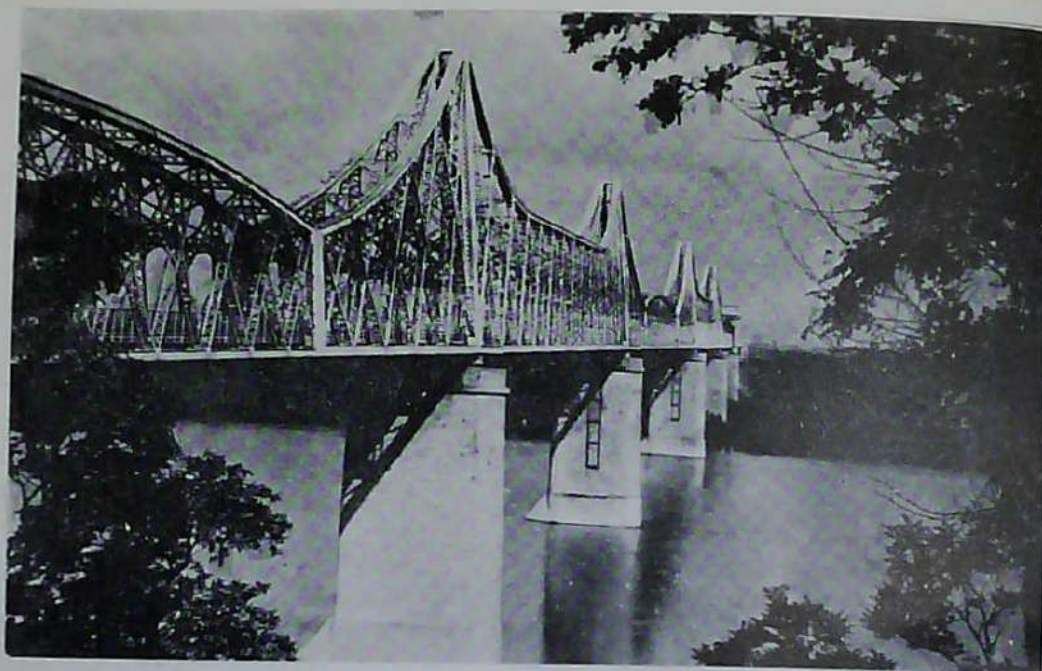
Le pont sur le Danube de Cernavoda
